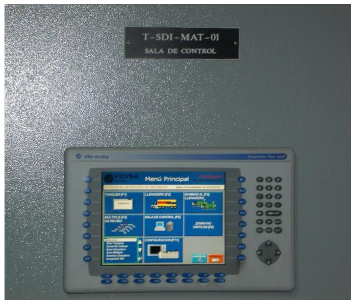
**Figura N° 12 Sistema de detección de incendios (S.I.D)**
