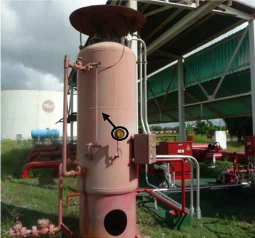
Figura N° 14 Tanque de Presurización
