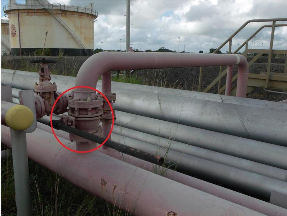
**Figura N° 4** *Válvula del Sistema de Anillos de Enfriamiento*
